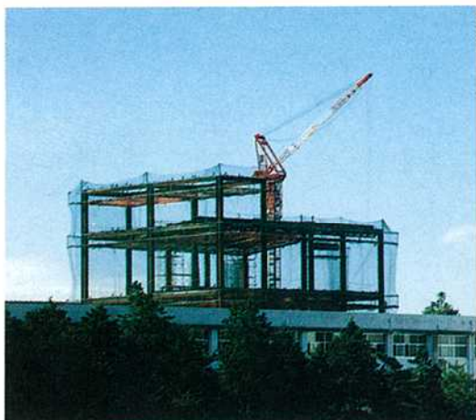
平成2年6月竣工予定
