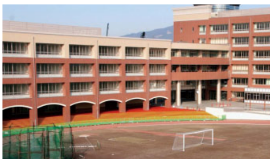
C棟完成（左側4階建ての建物）
